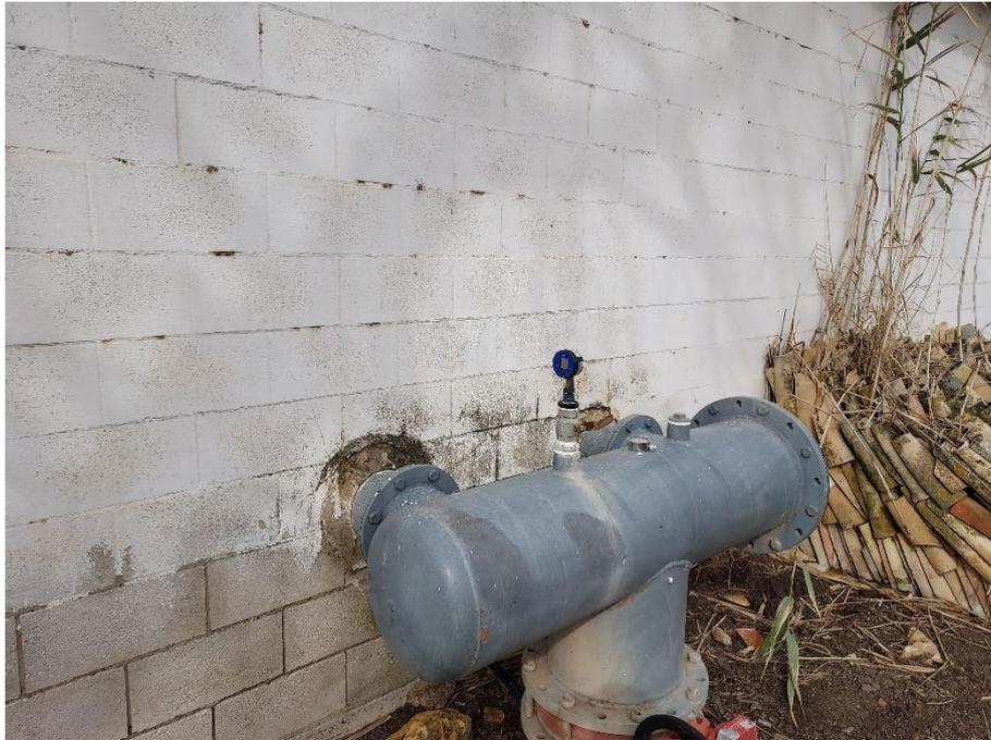
**Detalle sonda para medir presión en el colector de aspiracion**
