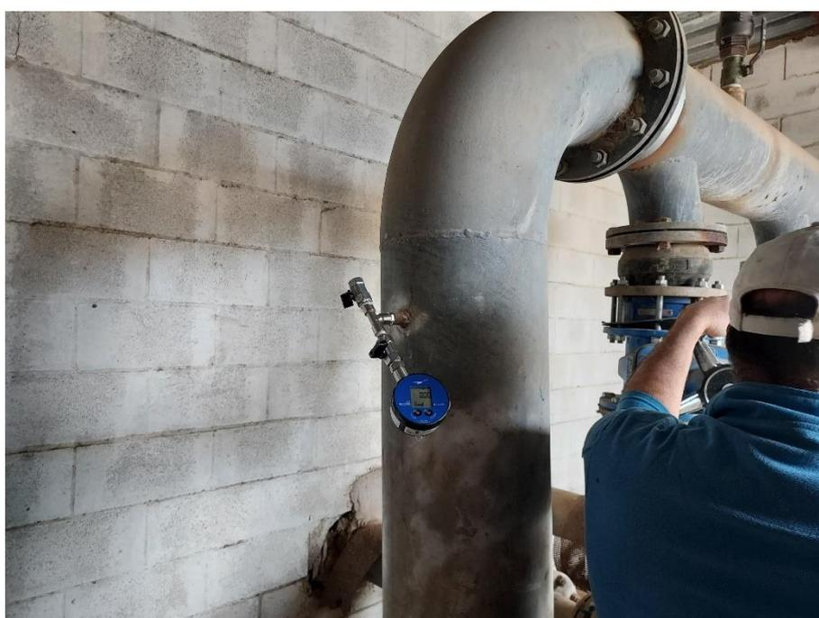
Detalle sonda para medir presión en el colector de impulsión
