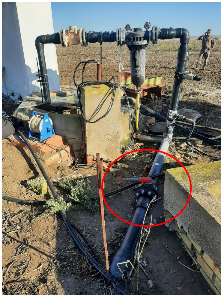
**Detalle válvula manual con la que regulan parcialmente para ajustar el caudal deseado**
