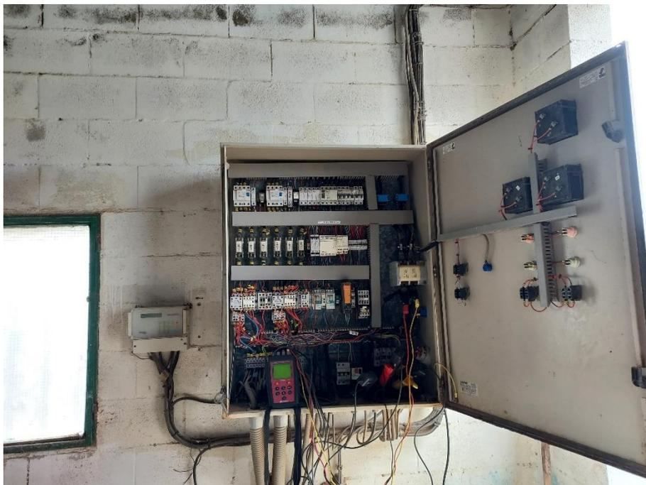
**Medida potencia absorbida con analizador redes eléctricas**
